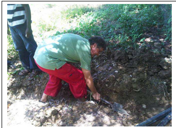
Pose des derniers tronçons de canalisation. Tout le monde s'y met ...
