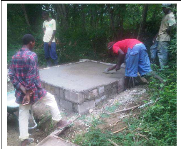
Travaux de maçonnerie
