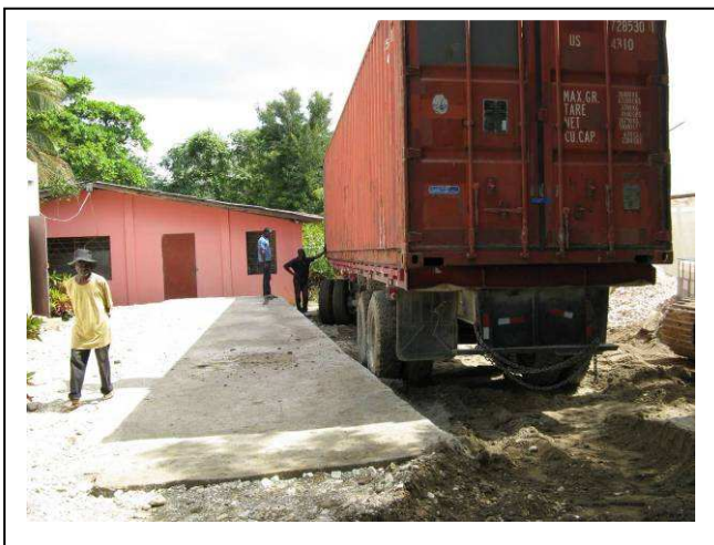
Le container de 40', maintenant vide, servira d'entrepôt, de bureau, et de support du réservoir surélevé
