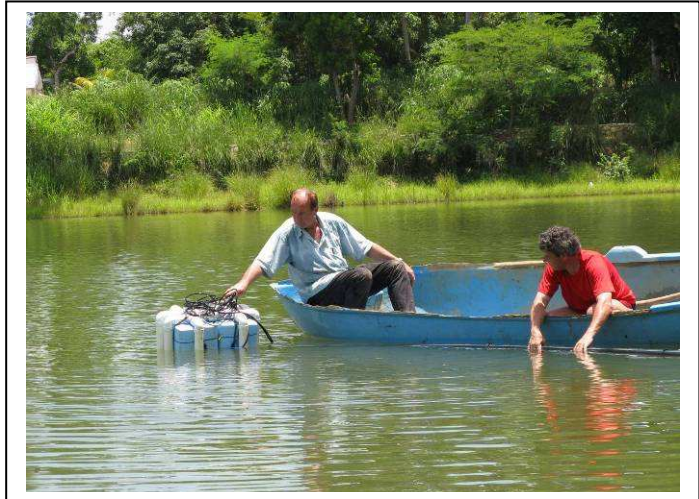
Pose de la prise d'eau flottante artisanale réalisée par Jean-Pierre et Daniel
